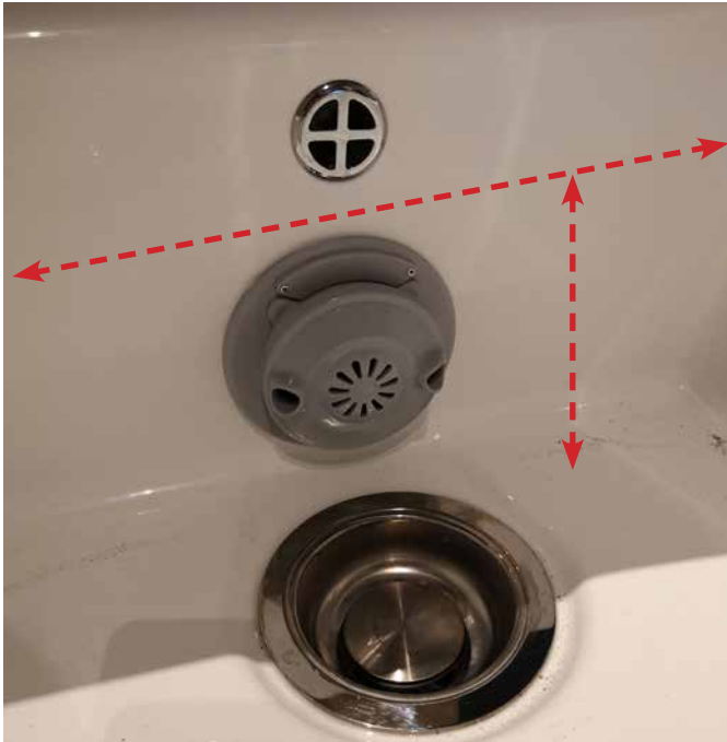
A. Il livello di acqua deve SEMPRE COPRIRE LA GIRANTE
