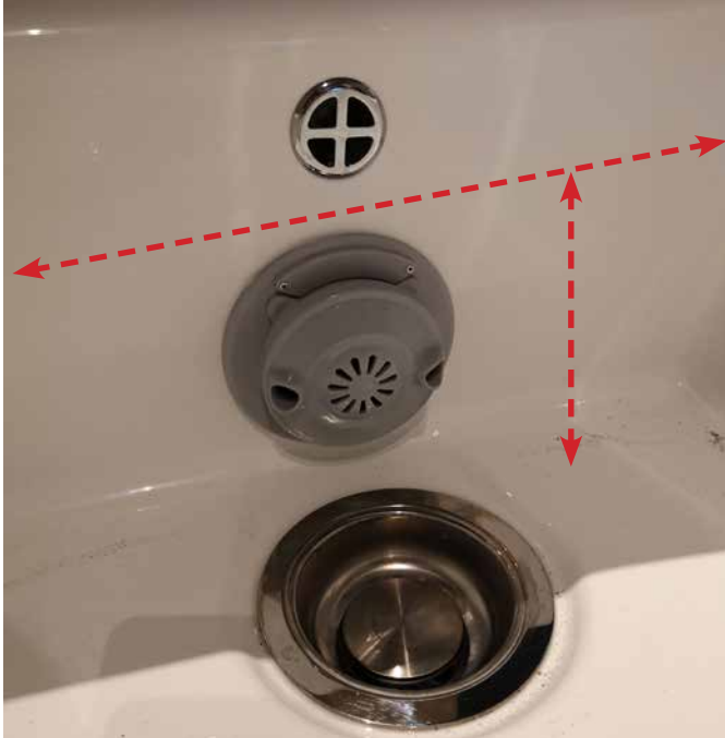
A. Le niveau de l'eau doit TOUJOURS COUVRIR le moteur hydro massage
